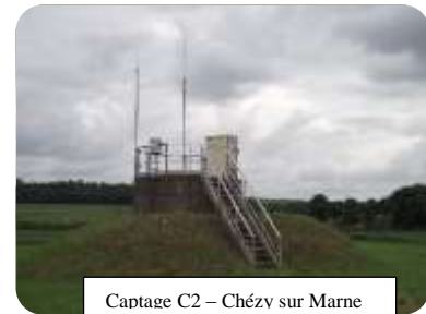
Captage C2 – Chézy sur Marne
